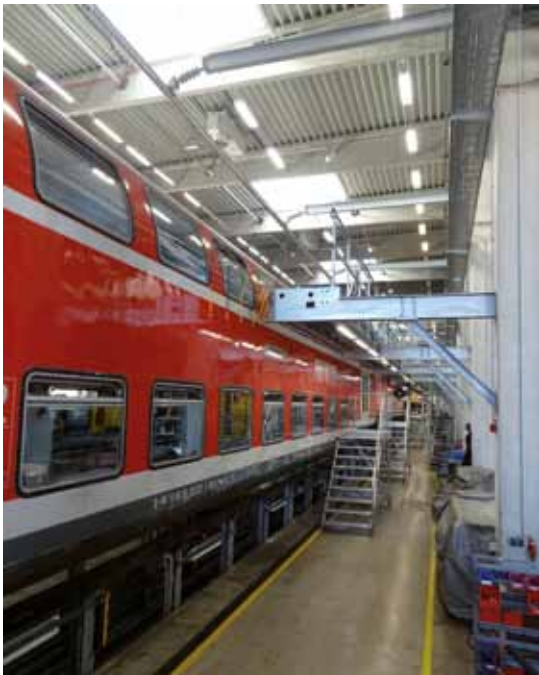
moderne Wartungshalle DB Regio Ulm.
