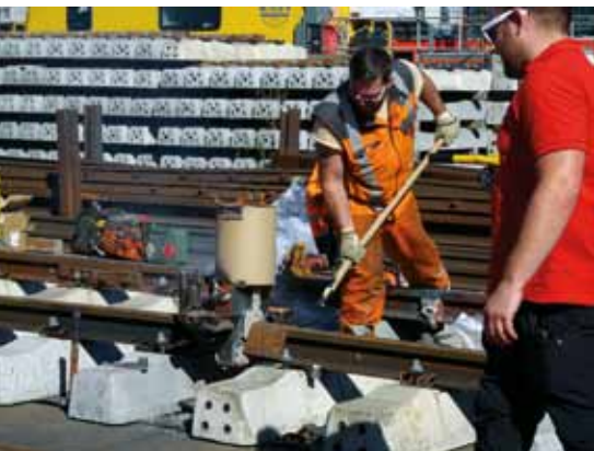
Thermitschweißen an einem Gleisjoch
