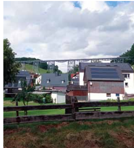
Ein beliebtes Fotomotiv ist das Markersbacher Viadukt - hier vom Bahnhof aus fotografiert
