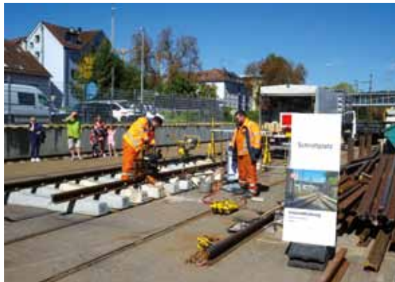
Schienenschleifen nach Schweißung
