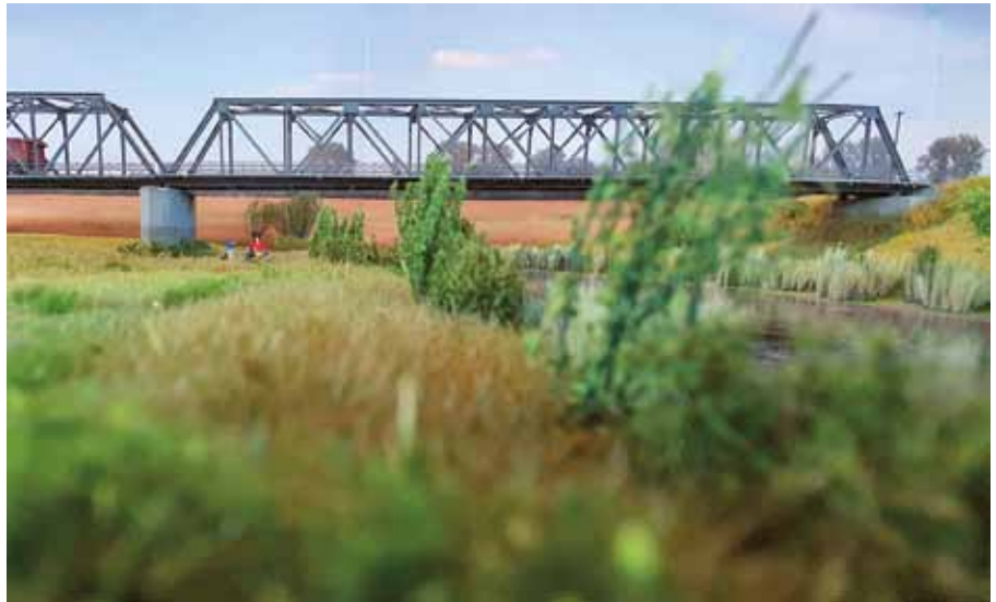
Alandbrücke bei Geestgottberg
