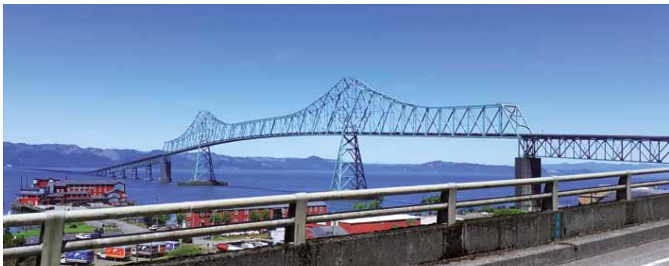
Die Astoria-Megler Bridge mit einer Gesamtlänge von 6.545 m
