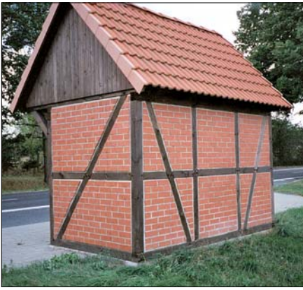
Neu erstelltes Wartehäuschen in Fachwerk-Klinker-Bauweise.
