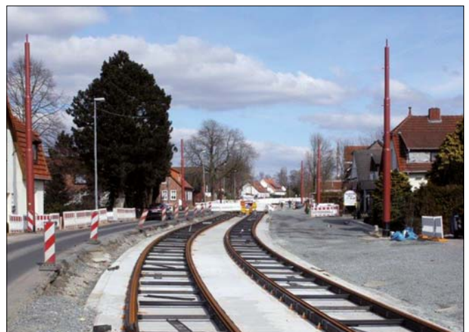
Der zweigleisig verlegte Streckenabschnitt in das Straßenbelag eingebettet. Aufnahme: 2013, bsag
