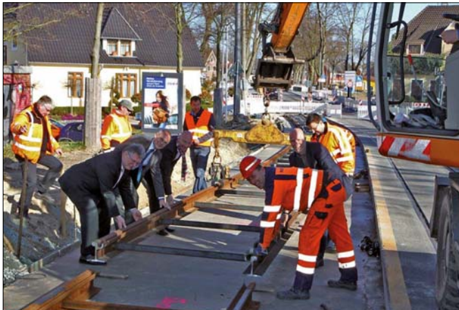
Verlegung des letzten Gleises im April 2014 - Foto bsag
