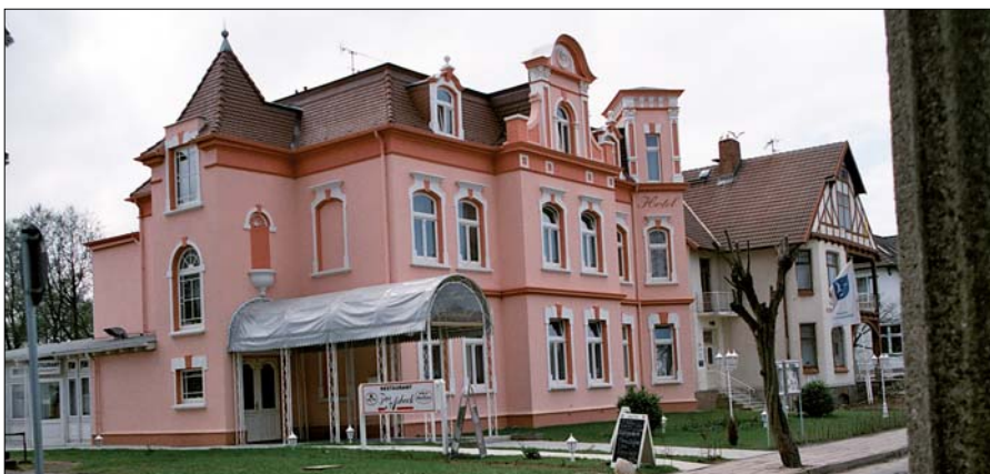
Dieses Gebäude aus der Jahrhundertwende zum 20. Jahrhundert als Beispiel für eine gelungene Renovierung.
