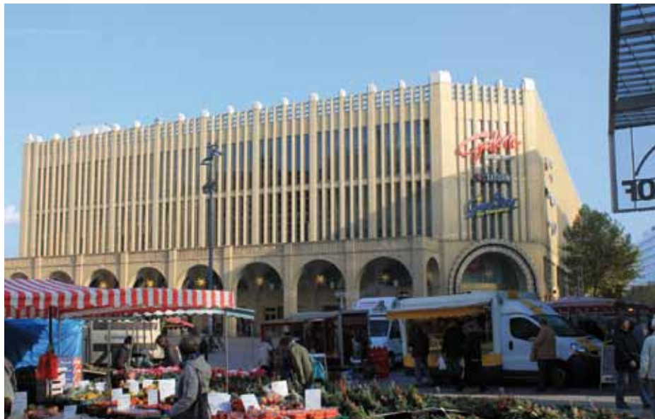
Kaufcenter „Galerie Roter Turm“
